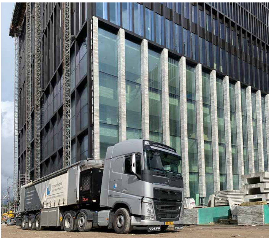
Kleine betonfabriek op locatie.
