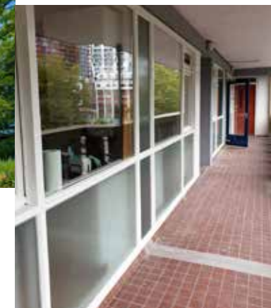
Van alle houten kozijnen zijn de ruiten vervangen.
