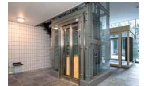
Panoramalift in het schalmgat van het trappenhuis.
