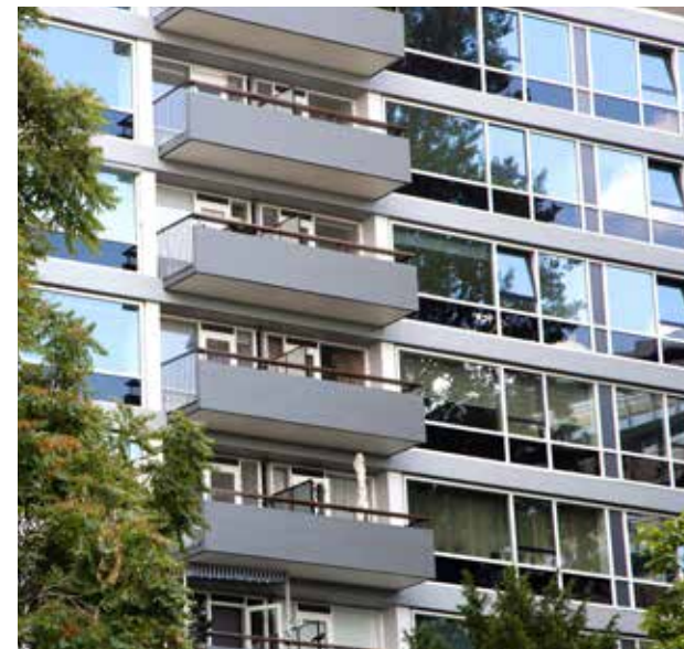
Het buitenschilderwerk bestond o.a. uit de kozijnen en het staal- en betonwerk.
